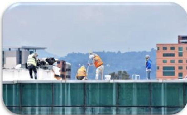
Techos. Aeropuerto Internacional La Aurora
