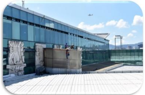
Caracoles del área de Bandas transportadoras del Aeropuerto Internacional La Aurora
