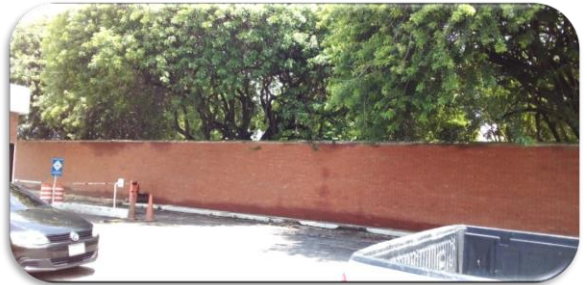
Cuadra AVSEC y fachaleta de ingreso por protocolo Aeropuerto Internacional La Aurora
