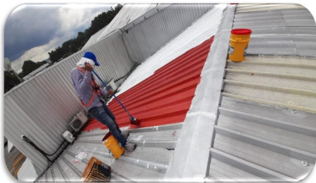
Impermeabilización y pintura de techos de Almacén General de la Dirección General de Aeronáutica Civil -DGAC-
